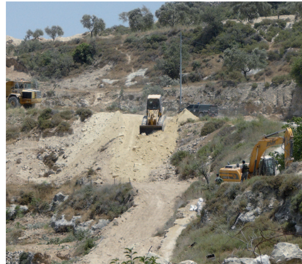
Israelische Bulldozer auf Ahmeds Land
